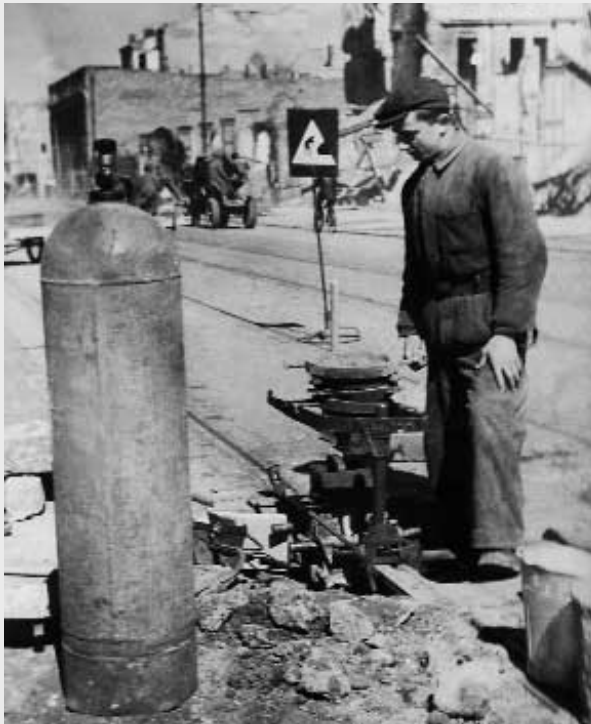
Warszawa, 1945, układanie szyn tramwajowych na ul. Marszałkowskiej.
